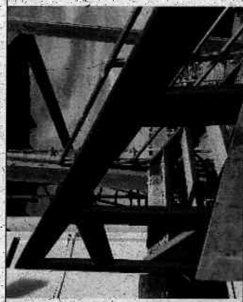
Fotografía N° 7: Estructura metálica esca era lado norte Edificio Comedores y Administración. Fecha fotografía: 28-02-2018
