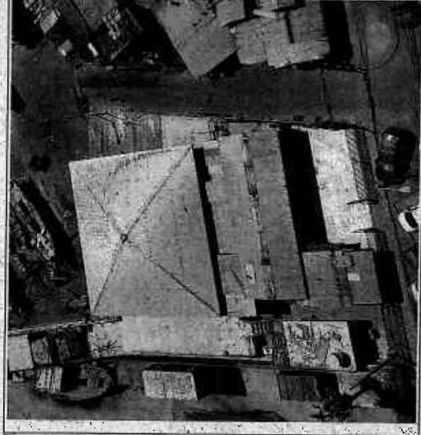
Fotografía N° 11: Estructura sombradero existente. Foto entregada por la Dirección de Obras Portuarias
