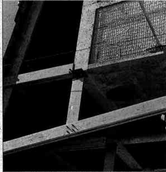
Fotografía N° 15: Pletina de anclaje ubicada entre los ejes 15 y W. Fecha fotografía: 21-02-2018
