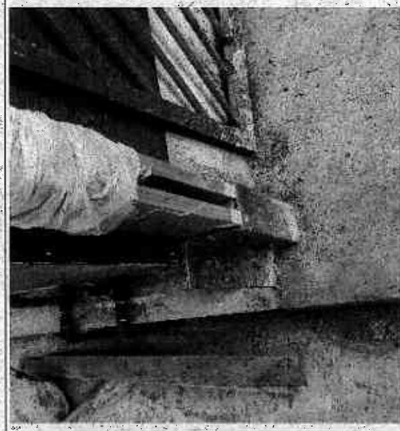
Fotografía N° 16: Sombreadero retirado. Foto entregada por la Dirección de Obras Portuanas
