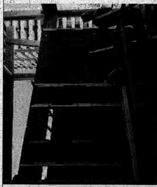
Fotografía N° 5: Ausencia de revestimiento de mortero en muros del 2do nivel del área de comedores y administración. Fecha fotografía: 23-02-2018
