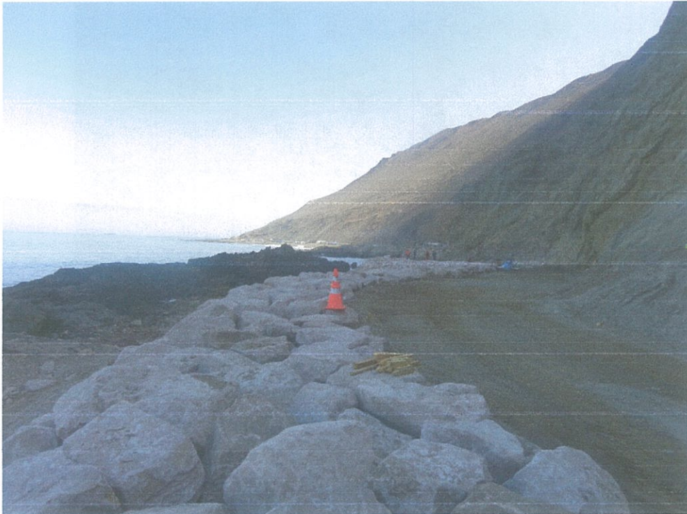
Fotografía N° 5, avance de enrocado en el tramo 3, 22 de enero de 2016.
