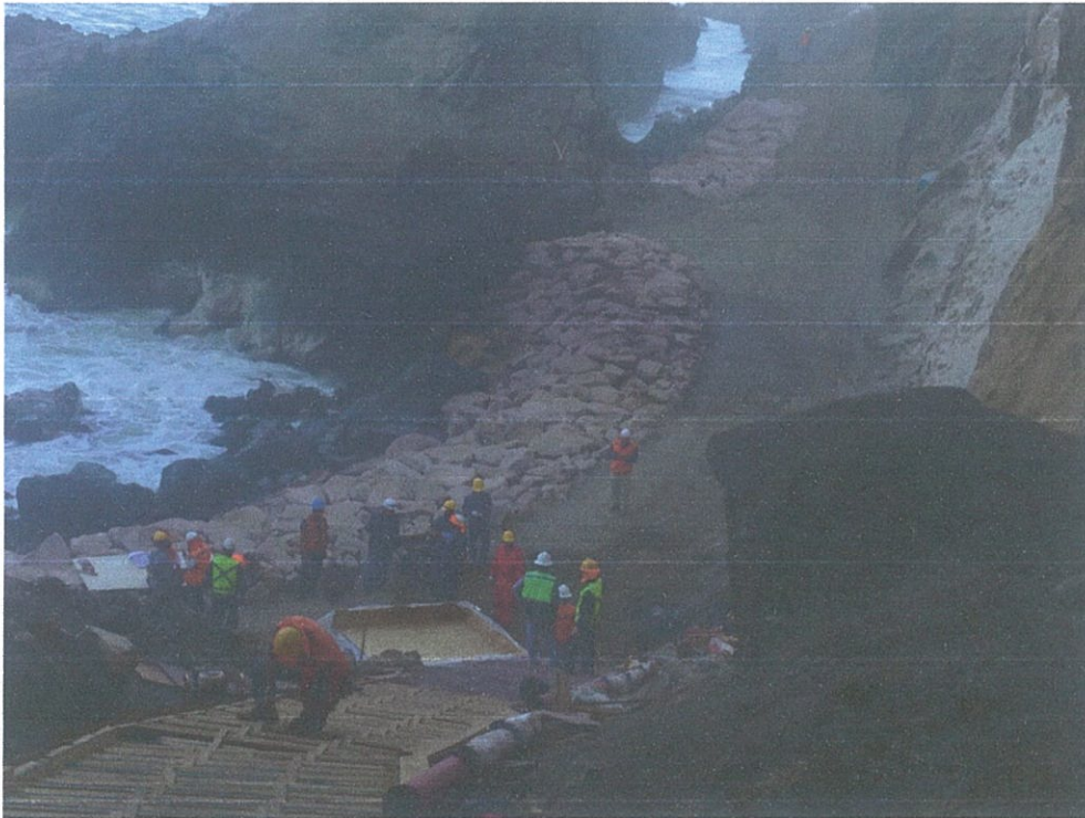
Fotografía N° 7, avance de enrocado en el tramo 5, 18 de enero de 2016.
