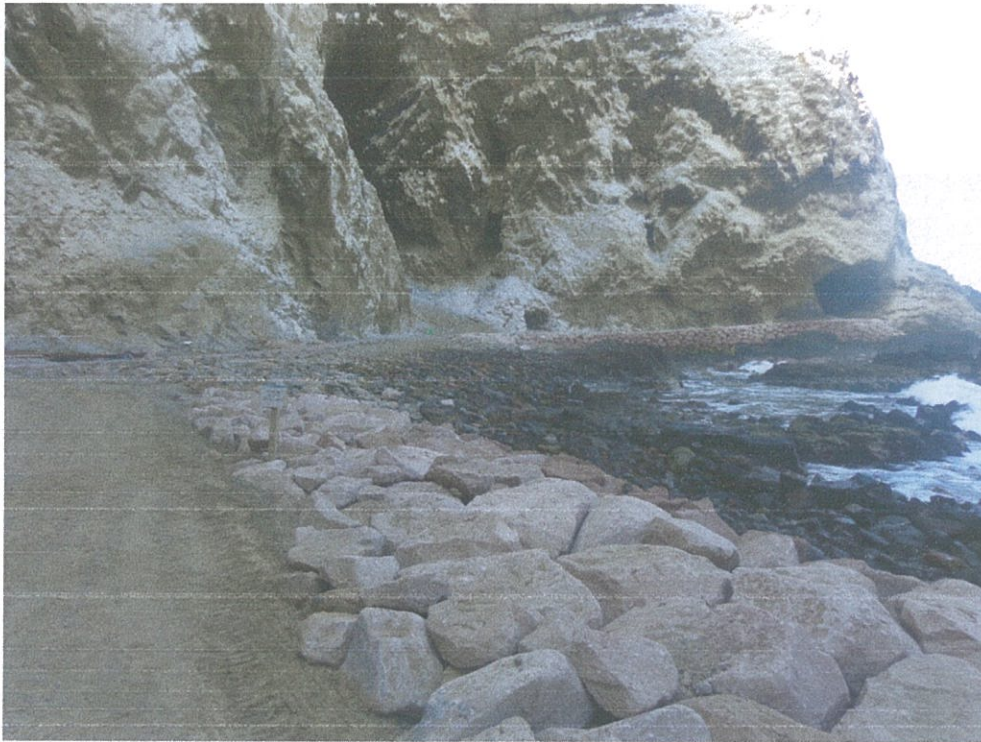
Fotografía N° 3, avance de enrocados en los tramos 5, 6, 7 y 8, 18 de enero de 2016.
