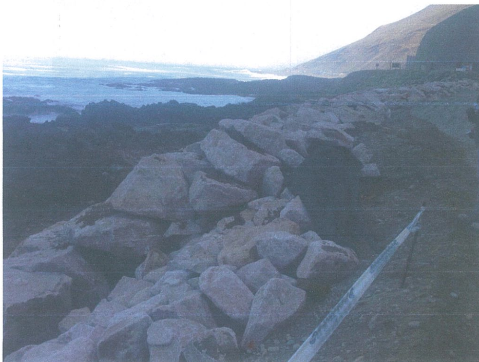
Fotografía N° 2, avance de enrocados en los tramos 2 y 3, 18 de enero de 2016.
