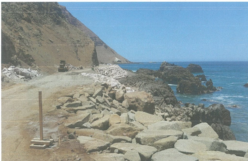
Fotografía N° 1, avance de enrocados en el tramo 1, 19 de enero de 2016.
