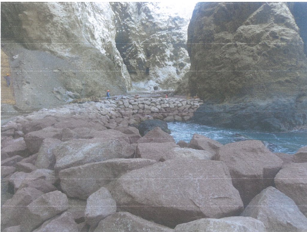
Fotografía N° 8, avance de enrocado en el tramo 5, 22 de enero de 2016.
