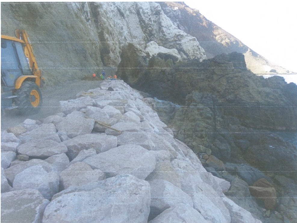
Fotografía N° 6, avance de enrocado en el tramo 3, 22 de enero de 2016.
