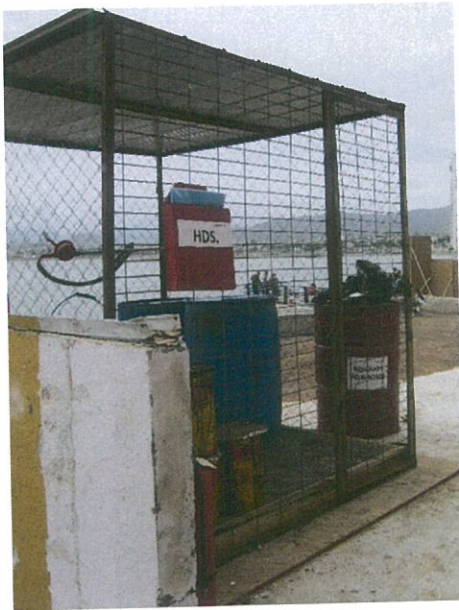
Fotografía N° 3 – 11/01/2016: Jaula de Residuos Peligrosos sin rotulación. Tambor fuera del recinto.
